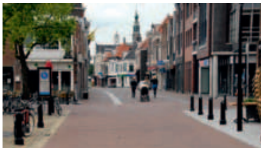
Bij de hoek van de Koemarkt met de Kalversteeg en de Dubbele Buurt sluit de belijning van bestratingsvlakken en hardstenen afwateringslijnen niet logisch aan.
